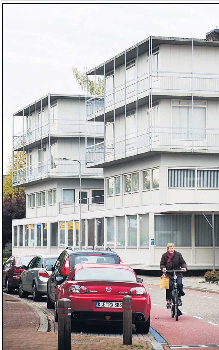
Het restaurant van De Fabriek in Maasbree (rechtsonder). Volgende projecten
